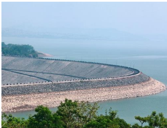
Hình 4. Đập thủy điện Yaly.
