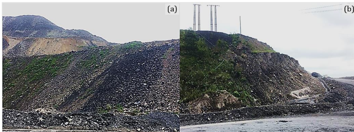
Hình 4. Hiện trạng xói lở và bồi lắng chân tầng tại bãi thải Bàn Nâu.
