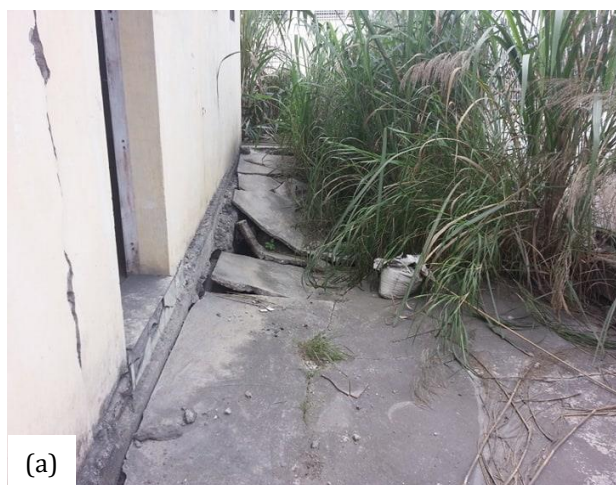
Hình 4. Sụt lún, gãy nền bê tông tại nhà vệ sinh (a) và sâu kho vật tư (b) trên bề mặt bãi thải mức +155 (chụp 11/2018).
