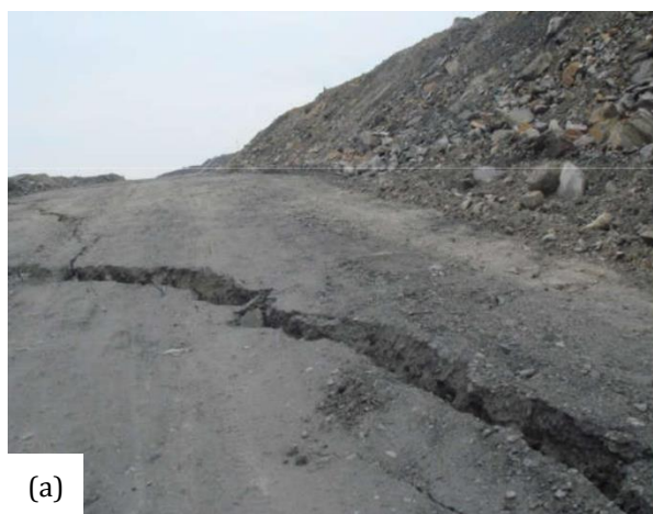
Hình 3. Dấu hiệu hiện tượng sụt lún trên bề mặt bãi thải mức +155.
