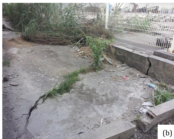
Hình 4. Sụt lún, gãy nền bê tông tại nhà vệ sinh (a) và sâu kho vật tư (b) trên bề mặt bãi thải mức +155 (chụp 11/2018).
