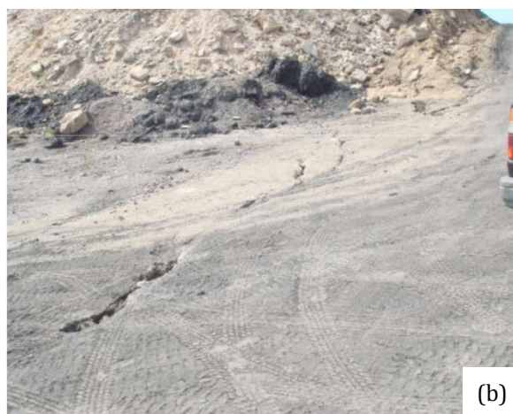
Hình 3. Dấu hiệu hiện tượng sụt lún trên bề mặt bãi thải mức +155.
