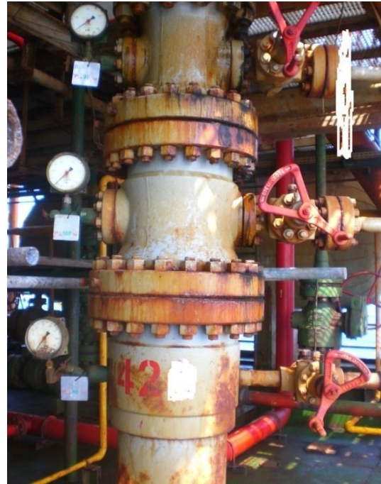
Hình 1. Thiết bị đầu ống chống và các đồng hồ chỉ báo áp suất GOC
