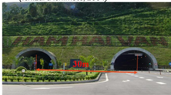
b) Khoảng cách hai đường hầm Hình 1. Dự án hầm Hải Vân.
