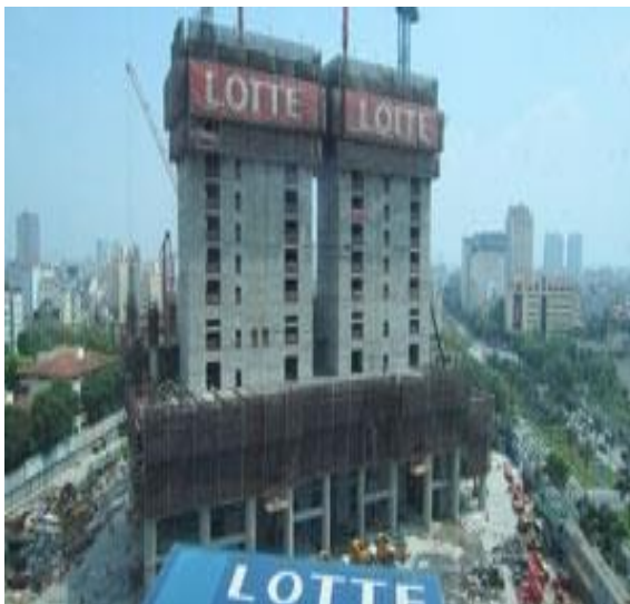
Hình 6. Hai phần kết cấu lõi (Core) của tòa nhà Lotte đang thi công
