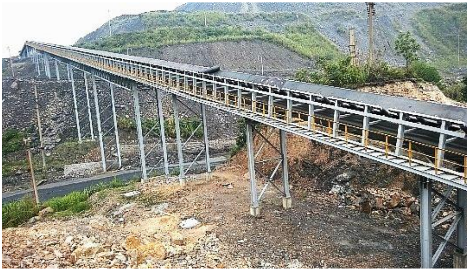
Hình 17. Hệ thống tuyến băng tải đá mỏ than Cao Sơn.
